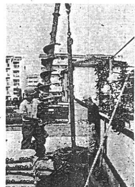
鉄骨を入れて地盤改良
