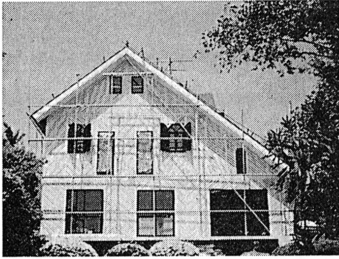
下地板を斜めに張れば耐震性が増す(伊東市の別荘)
