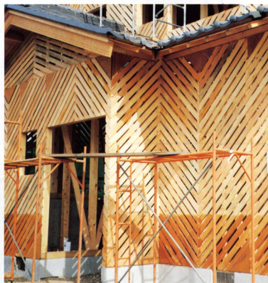
TIP構法は下地板を斜めに張るところに特徴がある。
