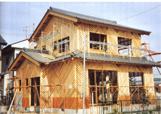
外部耐震壁には幾何学的な美しさがある。
