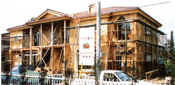
TIP構法だと、工事中も揺れが少ない。
