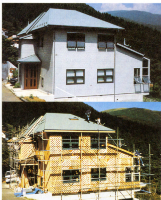
上は平成3年春に完成した熱海の武田邸竣工写真。 TIP構法による第1号住宅で、下はその工事中の外観。
