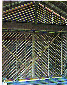
建築中の斉藤さん宅の内側から斜め張り下地板を透かし見る
