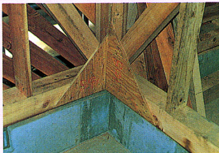
ガゼットプレートで筋交いをしっかり固定
