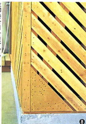
柱脚接合用合板ガゼットプレート
